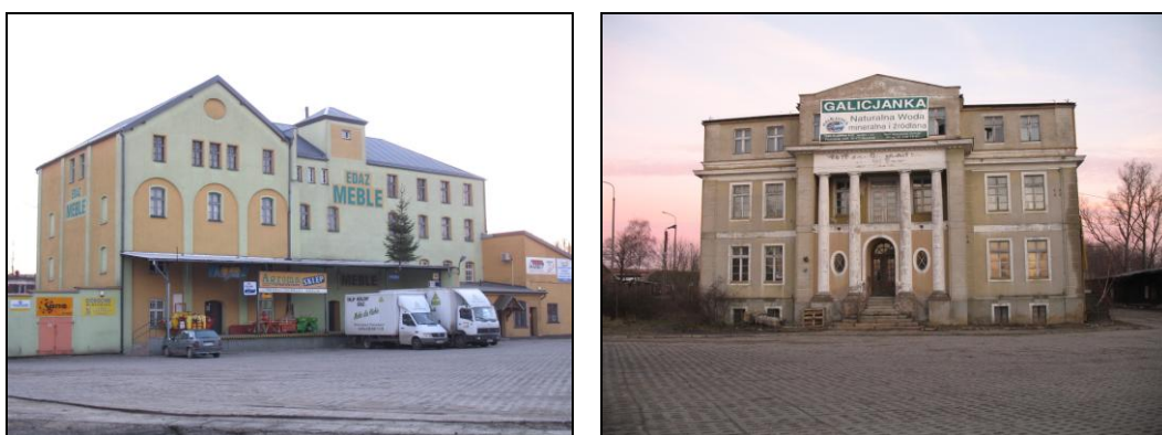
Fot. Budynek młyna parowego i domu jego właściciela.
