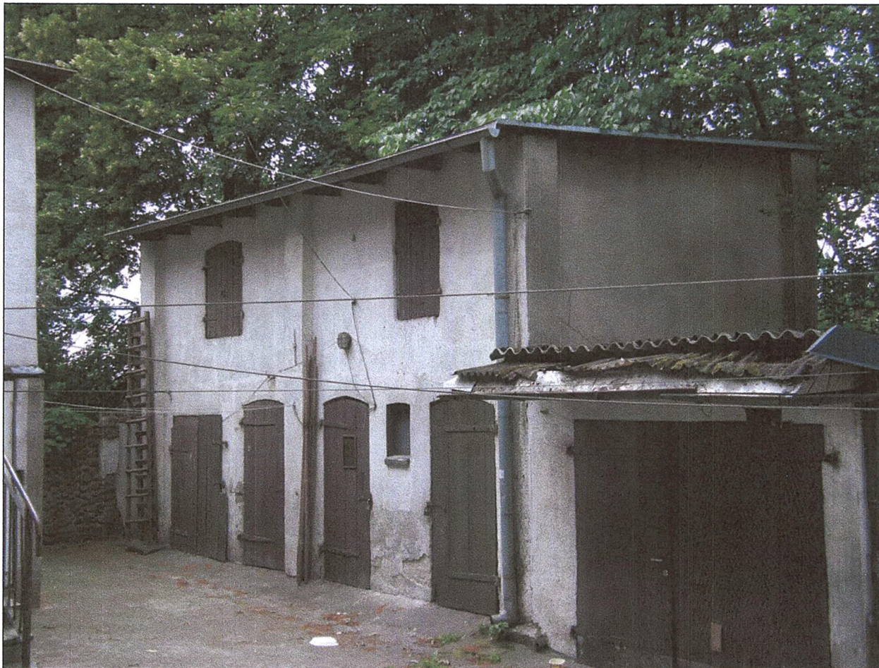
Elewacja frontowa (Fot. z VII.2015r)
